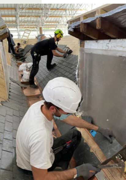
L'équipe des couvreurs au travail sur le toit du château
