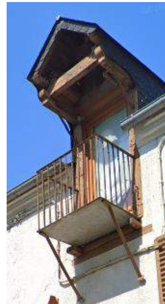
Lucarne meunière engagée dans le mur. On les trouve encore au-dessus des boulangeries.
