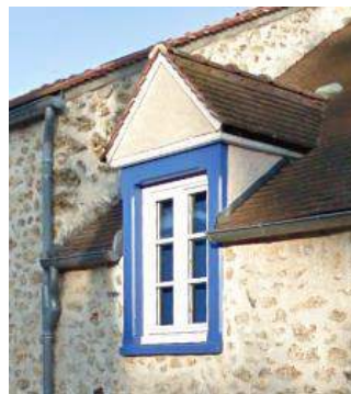
Lucarne à fronton maçonnée engagée
