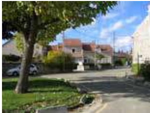
Construction de logements aidés au sein d'un hameau (Mesnil-Saint-Denis)
