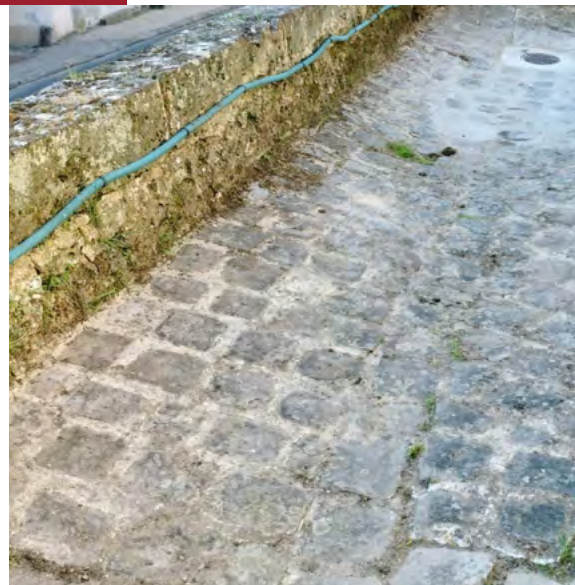
Ci-dessus, photos prises après travaux : toiture de l'église et cour pavée intérieure nettoyées
